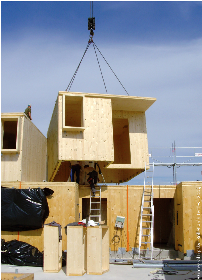
LES BOÎTES EN BOIS DES LOGEMENTS ÉTUDIANTS entièrement préfabriquées en atelier puis montées et assemblées sur le chantier
